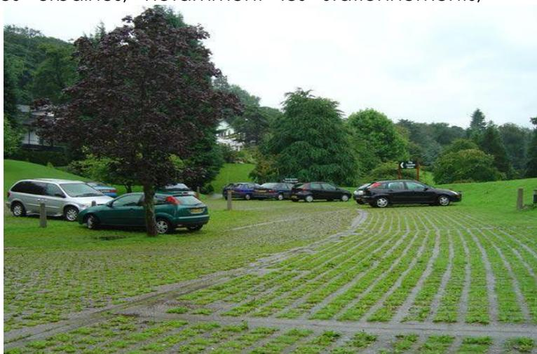
*Surface perméable - dalles de béton alvéolées*
