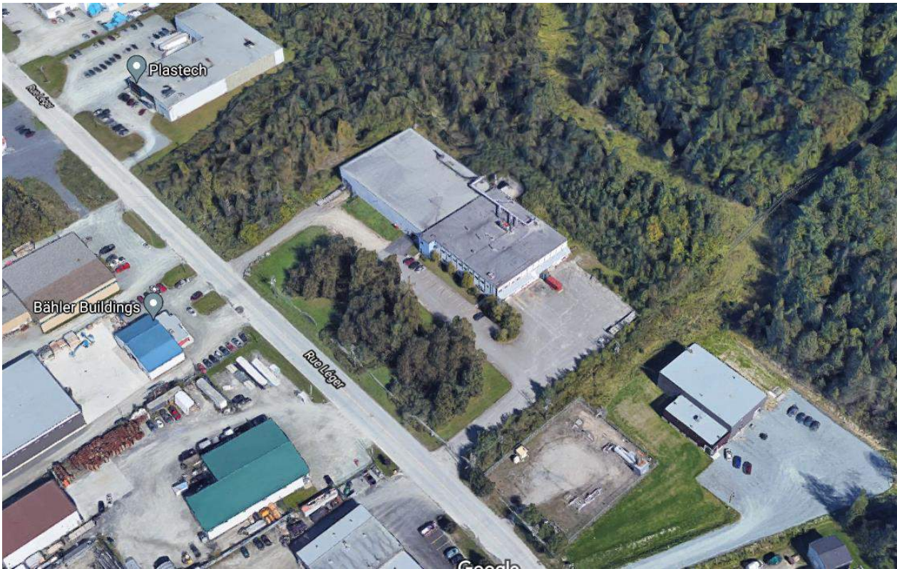
Vue aérienne du 290, rue Léger
