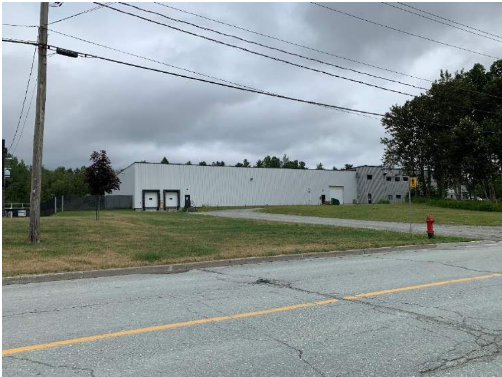
Façade principale du bâtiment situé au 290, rue Léger
