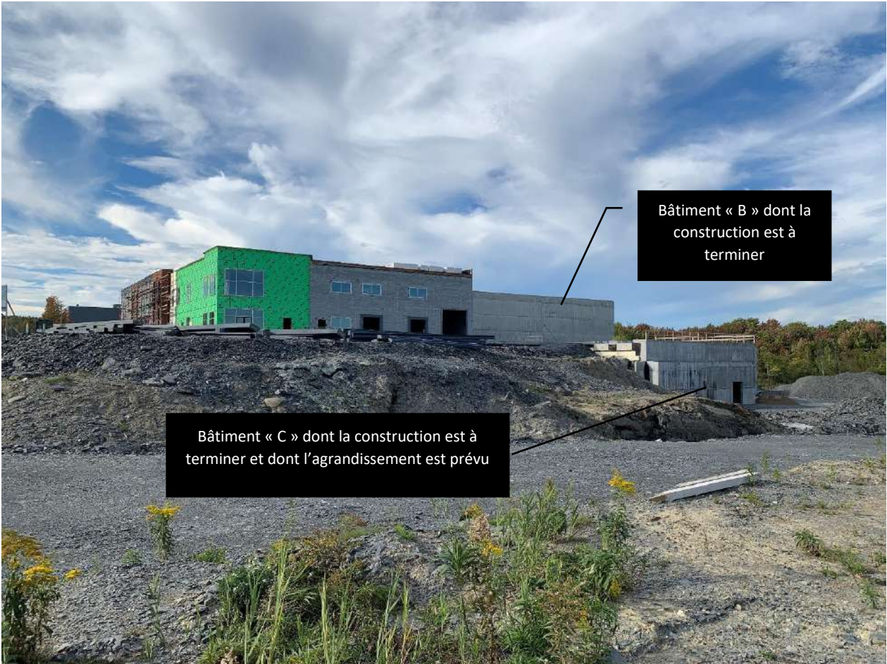
Vue de la façade latérale droite du 835-839, rue Joseph-Louis-Mathieu
