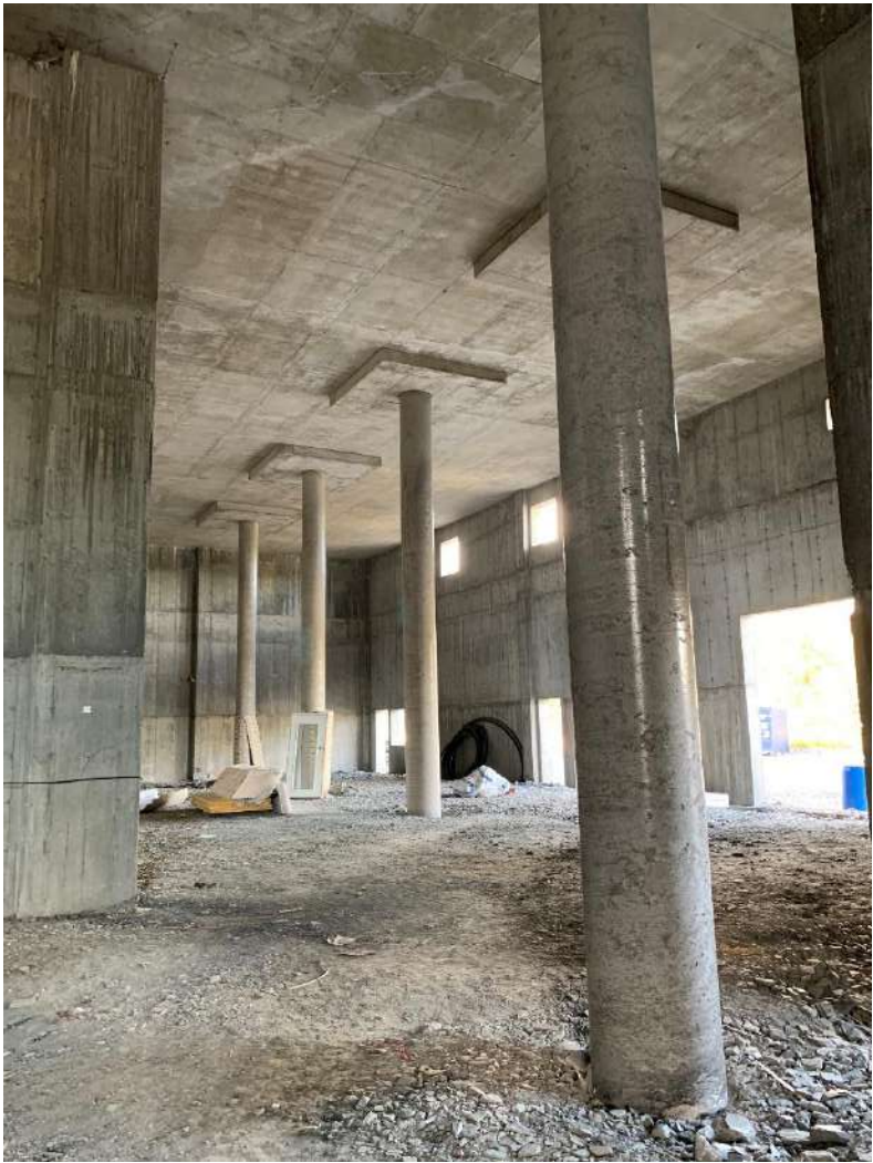
Partie « B » en sous-sol dont la construction est à terminer
