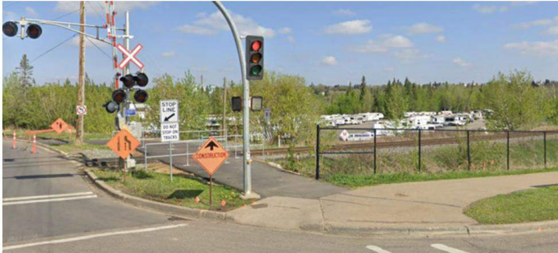
Figure 5.13 – Passage à niveau à St-Albert (Alberta).
