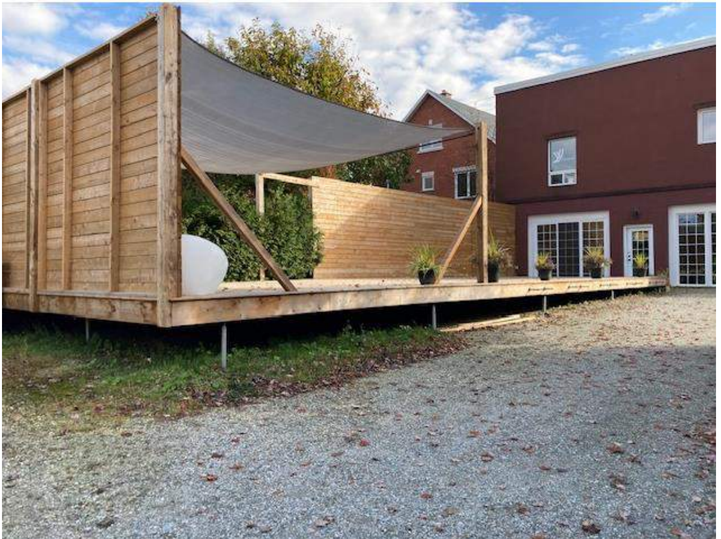
Vue de la plateforme aménagée dans la cour arrière munie de murs d'intimité. Source : Service de la planification et de la gestion du territoire, photo datée du 19 octobre 2023.
