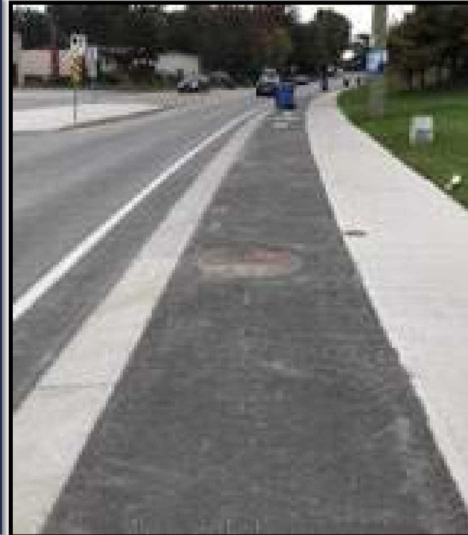
Piste cyclable surélevée séparation physique
