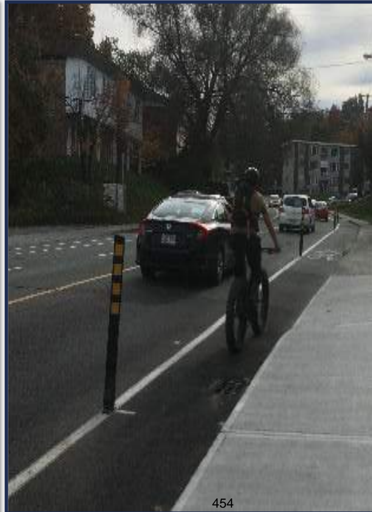
Piste cyclable sur chaussée séparation physique
