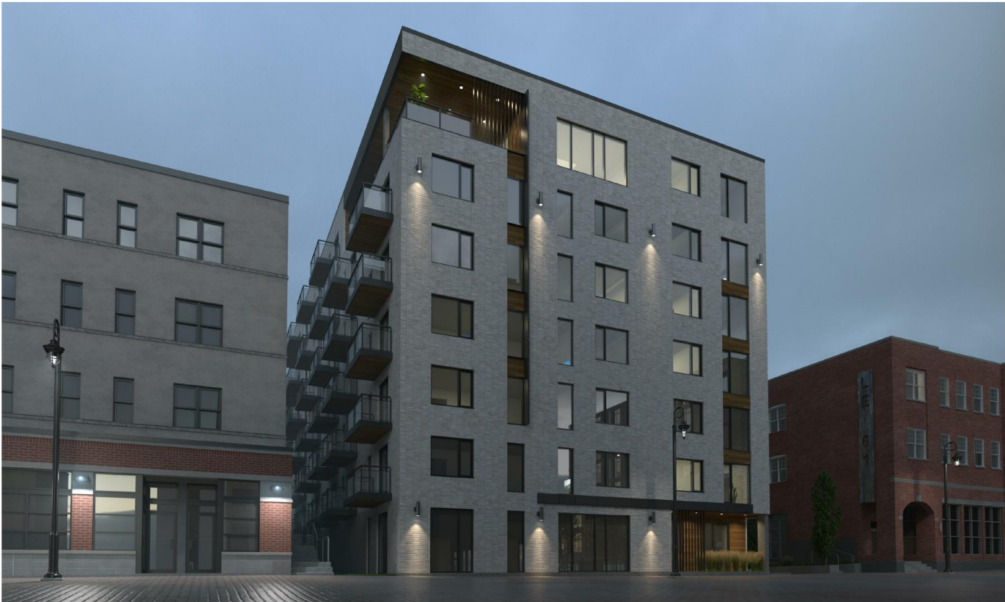
Vue de la rue Wellington Sud
