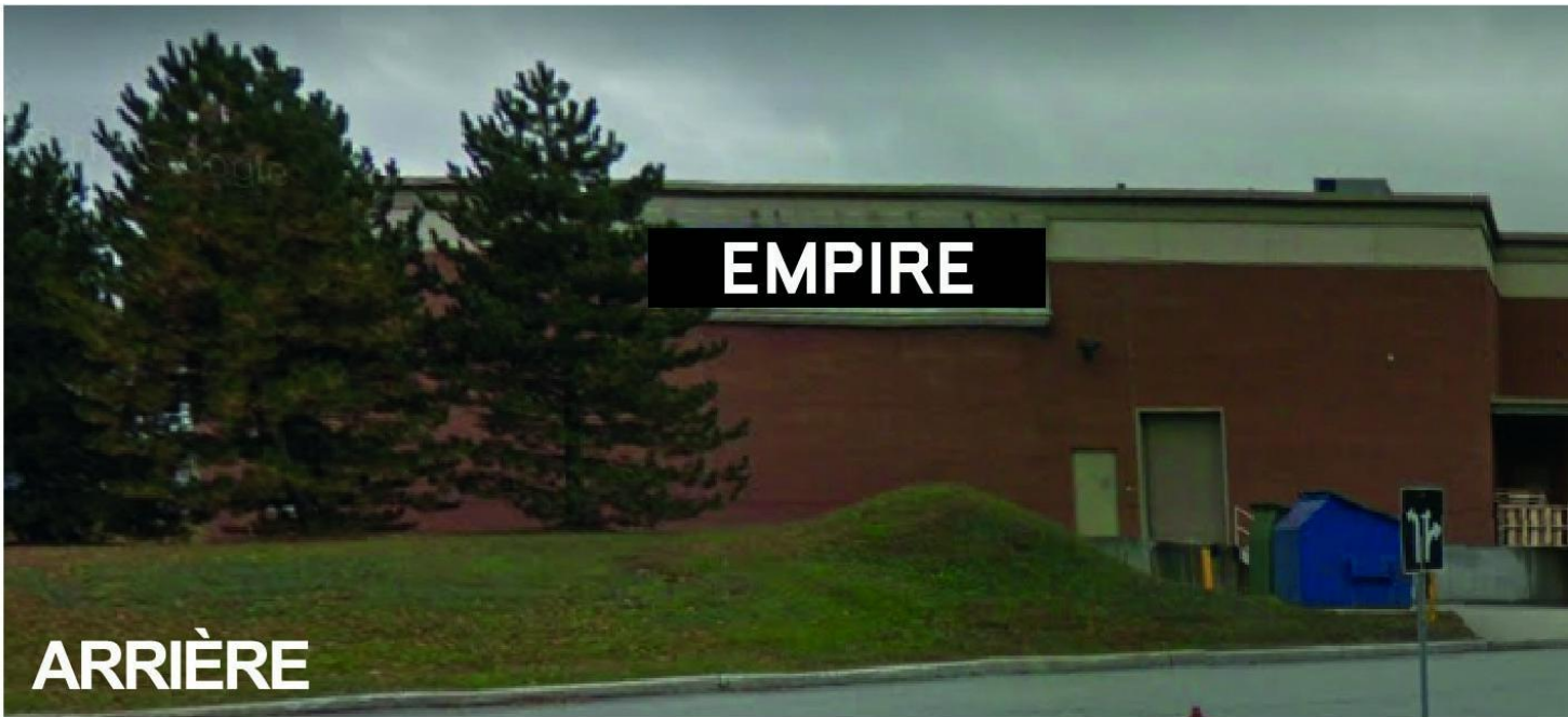
Vue de l'élévation arrière du commerce situé au 2905, boul. de Portland.
