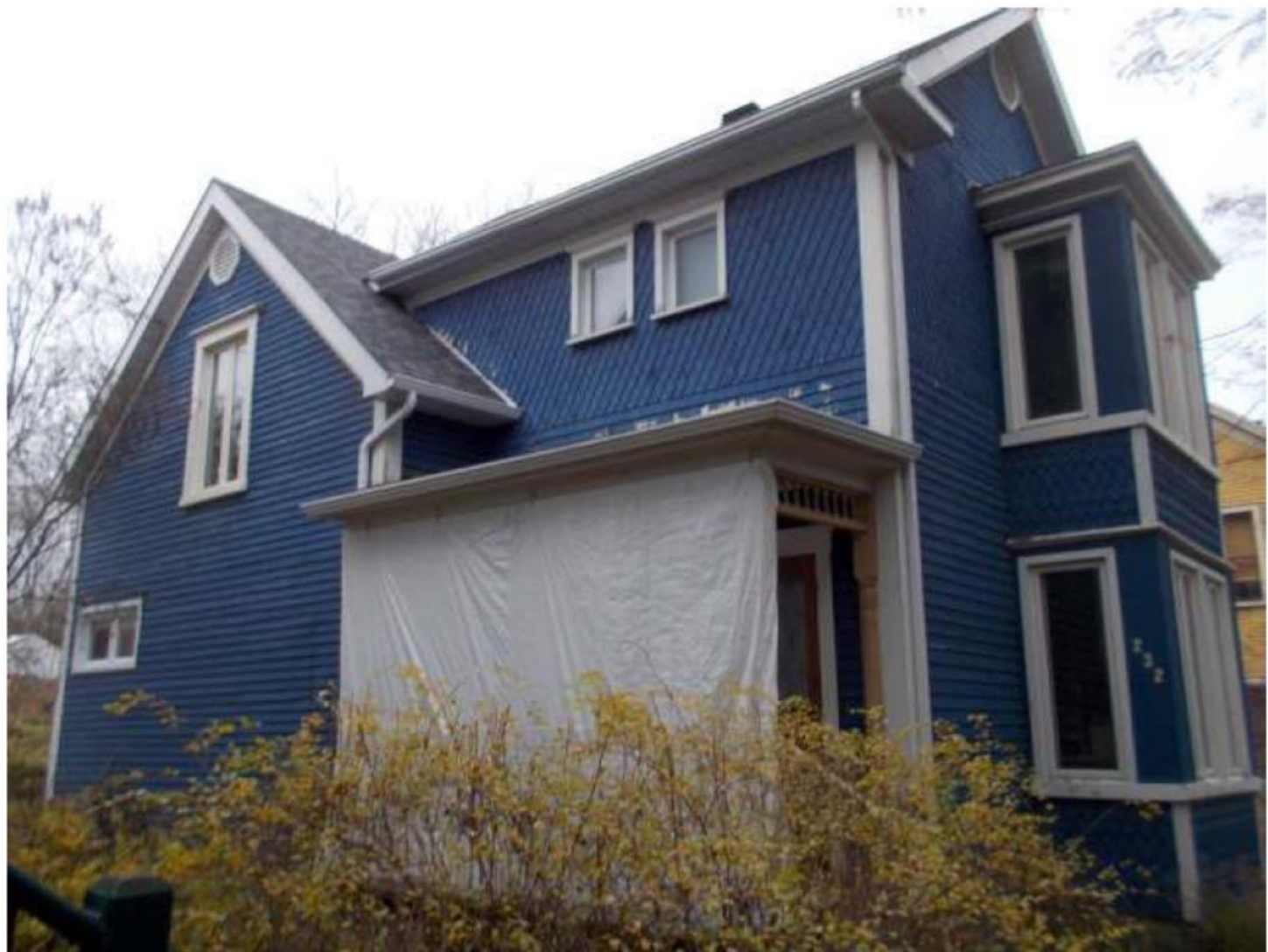
Façade avant de la résidence construite en 1897.
