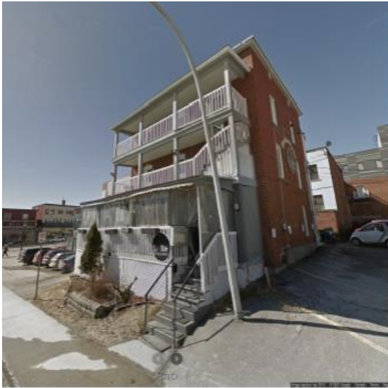
Façades latérale droite et avant existantes
