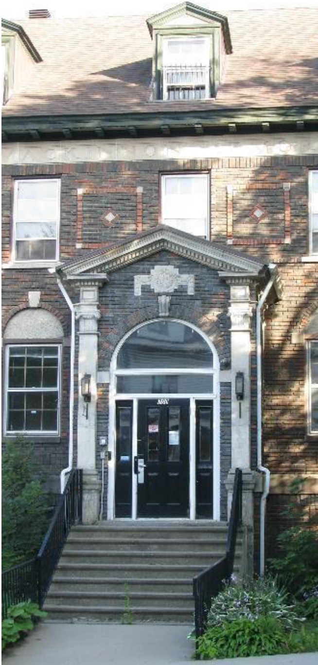
Vue agrandie sur l'entrée principale.
