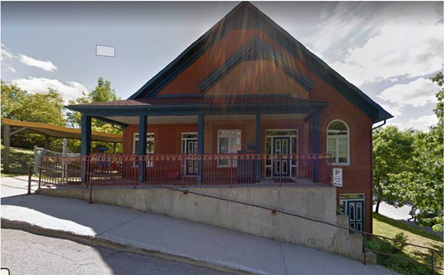
Façade latérale gauche située sur la rue Peel.
