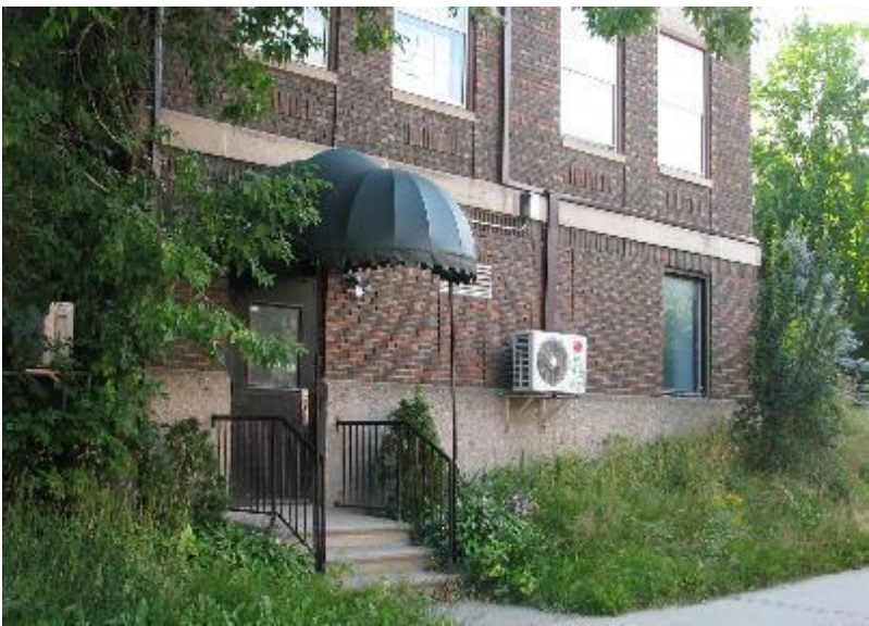
Vue agrandie sur l’entrée donnant sur la rue William du bâtiment.
