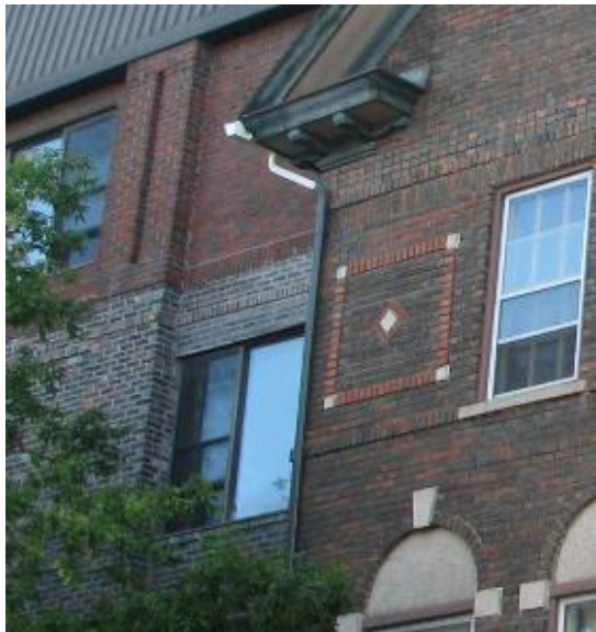
Vue agrandie sur les deux modèles de fenêtres déjà en place sur les élévations.
