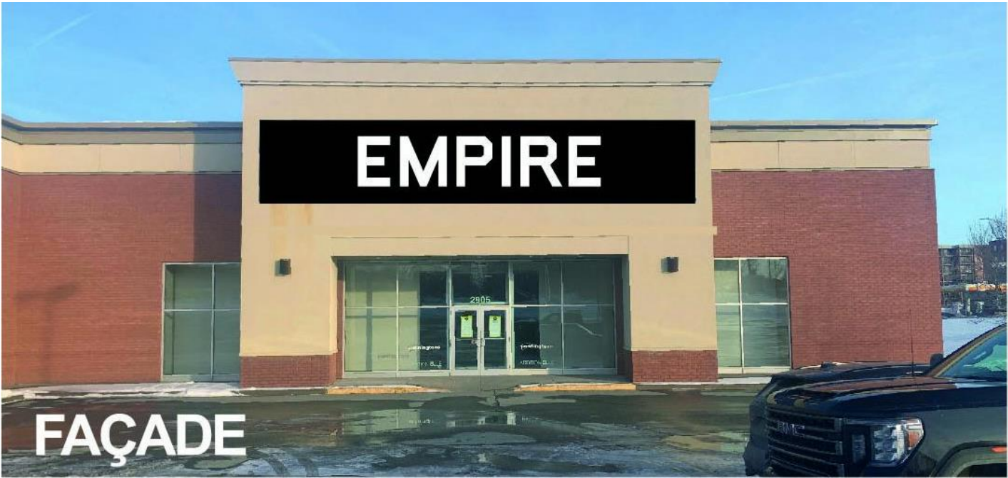
Vue de l'élévation principale du commerce situé au 2905, boul. de Portland.
