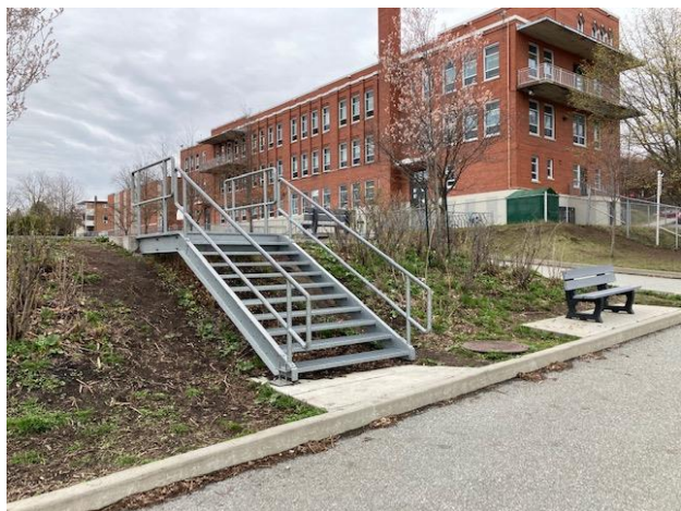
Espace vert et escalier vers la cour arrière du bas (ouest)
