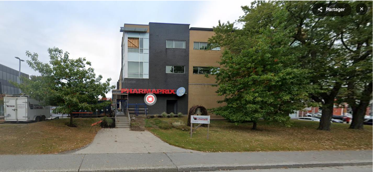
Façade avant donnant dans la rue King Ouest.
