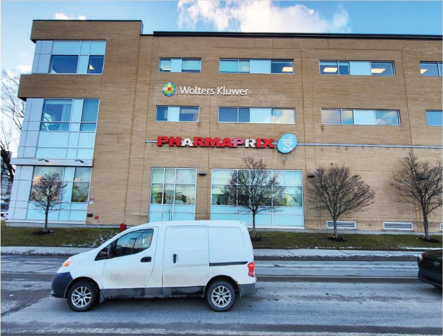
Façade latérale droite donnant dans le boulevard Jacques Cartier Nord.
