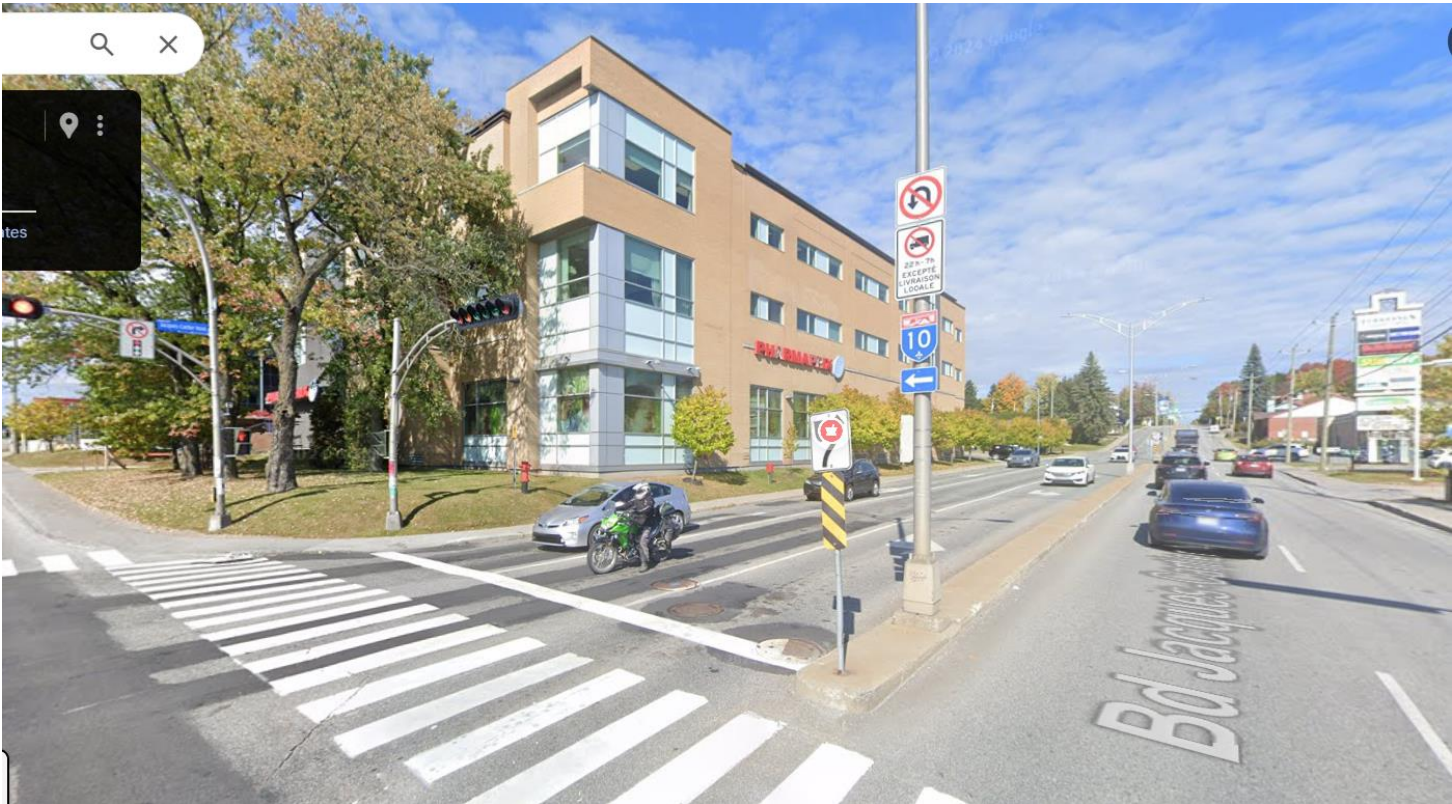
Façade donnant dans le boulevard Jacques Cartier Nord.
