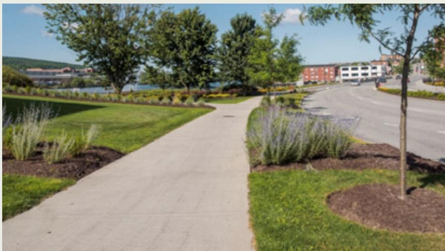
Le trottoir de béton le long d'une voie de circulation ou en banquette, à quelques mètres en retrait de la chaussée.
