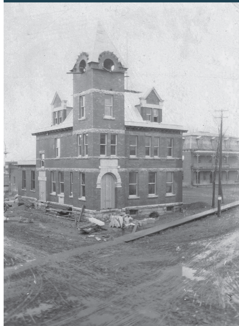
La construction du bureau de poste de Marieville, en 1910. À droite, on aperçoit l'hôtel Marieville (Bessette)
