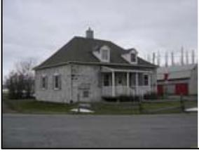
« **toiture à croupe** » : toit formé de quatre versants. Les deux longs pans trapézoïdaux se rencontrent au sommet. Les deux autres pans, situés aux extrémités du bâtiment, sont triangulaires et de plus petite dimension.
