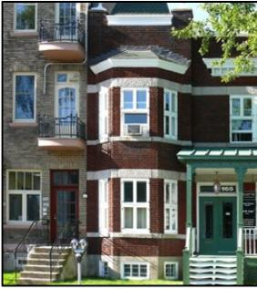
« **oriel** » : fenêtre en encorbellement faisant saillie sur un mur de façade au niveau de plusieurs étages.
