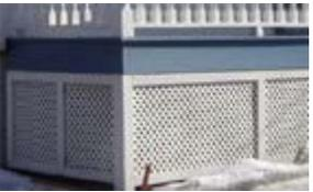
« **treillis** » : entrecroisement de lattes, de fils métalliques formant claire-voie. Assemblage de poutrelles métalliques rivetées. Souvent utilisé comme jupe de galerie. Exemple : potrellis.
