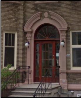
« **Pilastre** » : pilier engagé, colonne plate engagée dans un mur ou un support et formant une légère saillie. Synonyme : ante.
