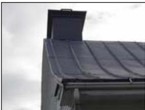
« **tôle à baguettes** » : type de couverture en tôle couramment utilisée au 19<sup>e</sup> siècle. Cette technique ancienne doit son nom aux baguettes de bois sur lesquelles sont assemblés les joints des feuilles de métal. De formes variables selon les époques et les régions, ces tasseaux de bois sont disposés perpendiculairement au débord du toit et leur espacement dépend de la largeur des tôles utilisées. Ainsi, le patron varie selon la forme de toits.
