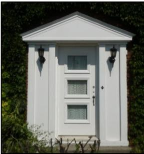
« **fronton** » : couronnement d'un édifice ou d'une partie d'édifice consistant en deux éléments de corniche obliques, ou en une corniche courbe, se raccordant avec la corniche d'un entablement formant ainsi un fronton triangulaire, semi-elliptique ou semi-circulaire.
