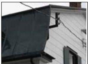
« **brisis** » : partie inférieure et généralement très abrupte d'un versant de toit brisé, mansardé par opposition aux terrassons. La ligne de brisis est l'arête séparant les deux pentes du versant.
