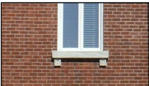
« **allège** » : partie maçonnée basse sur laquelle s'appuie une fenêtre
