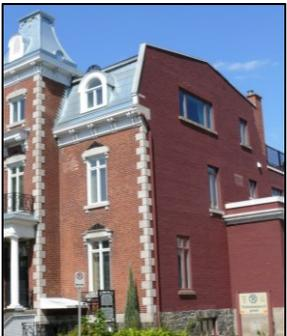
« **mur coupe-feu** » : ouvrage à l'épreuve du feu, en maçonnerie, qui s'élève verticalement sur une certaine longueur et qui sert à enclore, à isoler des espaces d'un bâtiment en cas d'incendie. Dans l'architecture urbaine du Québec des 17e, 18e et 19e siècles, mur mitoyen en maçonnerie se poursuivant au-dessus des toits pour contrer la propagation des incendies.
