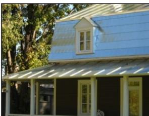
« **auvent** » : petit toit en saillie couvrant un espace à l'air libre devant une baie, une façade, ou sur une galerie pour se protéger de la pluie ou du soleil. L'auvent peut être soutenu par des colonnes, des piliers. Les mots de pare-soleil et d'avant-toit sont des synonymes d'auvent.
