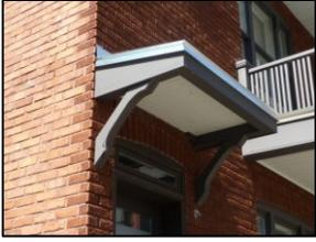
« **marquise** » : structure horizontale sans appui au sol placée au-dessus d'une porte d'entrée pour servir d'abri contre la pluie. Synonyme d'abri et d'avant-toit.
