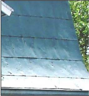
« **tôle en plaque** » : semblable à la tôle à la canadienne, la tôle en plaque est constituée de rectangles de tôle cloués dans le sens de la pente du toit. Les rectangles de tôle sont généralement plus grands que ceux utilisés pour la tôle à la canadienne.
