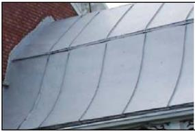
« **tôle pincée** » : tôle de couverture dont les joints sont pincés (joints plats) pour donner l'aspect de la tôle à baguettes.
