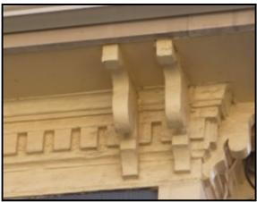
« **console** » : moulure saillante en forme de volute ou de S qui sert de support à une corniche ou à un balcon. Une corniche à consoles est une corniche constituée d'une série de moulures saillantes ou de consoles.
