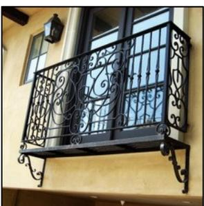
« **balconnet** » : garde-corps de baie de porte-fenêtre sans plateforme. Balcon de petite dimension.
