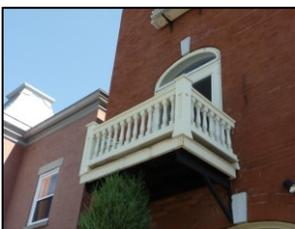
« **balcon** » : plateforme en saillie (à la différence de la loggia) sur la façade d'un bâtiment, généralement aux étages supérieurs, munie d'un garde-corps et qui communique avec les appartements par une ou plusieurs ouvertures. Contrairement à la galerie, le balcon n'est pas accessible à partir du sol.
