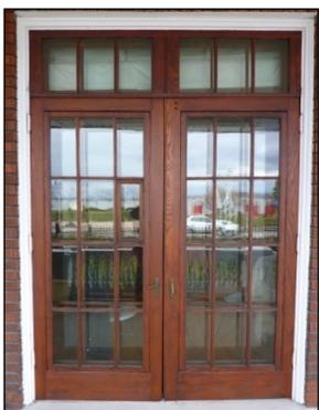
« **imposte** » : partie supérieure d'une baie de porte ou de fenêtre séparée par une traverse horizontale appelée traverse d'imposte. L'imposte peut être mobile ou fixe, pleine ou vitrée.
