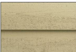
« **clin** » : panneau à recouvrement partiel dans un revêtement extérieur. Planches ou planchettes à clin ou à déclin : planches posées à l'horizontale, biseautées de façon à en amincir la partie supérieure et superposées de manière à ce que leur face exposée soit inclinée pour empêcher la pénétration de l'eau de pluie.
