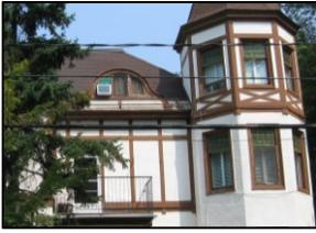
« **colombage** » : élément vertical d'une charpente à claire-voie dont les vides sont garnis de maçonnerie légère.
