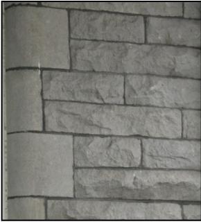
« **chainage d'angle** » : pilastre appareillé en pierre ou en brique incorporé à un mur pour le consolider ou à l'angle de deux murs pour en empêcher l'écartement. Le chainage d'angle est souvent appliqué sur les murs comme simple élément décoratif sans fonction structurale.
