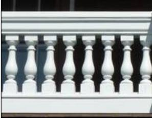
« **balustrade/garde-corps** » : rangée de balustres, fixée entre une lisse et une main courante formant appui, qui constitue un garde-corps ajouré dont la fonction est d'assurer la sécurité des lieux et qui participe au style du bâtiment.
