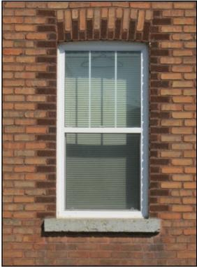
« **ouverture à arc surbaissé** » : ouverture dont la partie supérieure est constituée d'un arc dont la courbure est aplatie comparativement à l'arc en plein cintre. Arc très faible.
