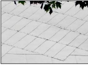
« **tôle à la canadienne** » : appareillage de couverture métallique reconnaissable à son patron rappelant une multitude d'écailles plates. Ces plaques de petites dimensions sont en fait des bandes de tôle pliées et chevauchées que l'on cloue obliquement au débord du toit.
