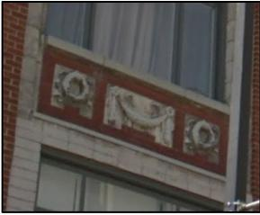
« **insertion de brique ou de pierre** » : intégration d'un matériau, d'un élément décoratif dans un mur, un appareillage régulier.
