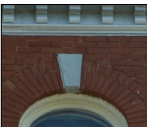
« **clé de voûte** » : pierre en forme de coin (claveau) placée à la partie centrale d'une voûte, d'un arc et servant à maintenir les autres pierres en place. Souvent sans fonction structurale.
