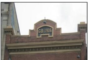
« **parapet** » : prolongement d'un mur au-dessus d'un toit plat. Le parapet est le bout de mur qui dépasse du toit, souvent au-dessus de la corniche. Il peut être tout simplement droit ou comporter une forme décorative.
