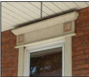
« **linteau** » : pièce horizontale de bois, de pierre ou de métal qui forme la partie supérieure d'une ouverture et soutient la maçonnerie. Le mot poitrail est un synonyme de linteau.
