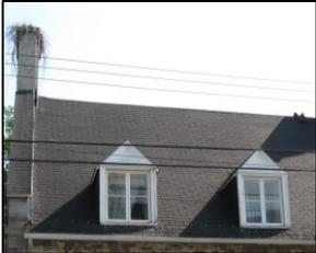
« **faîte** » : partie la plus haute du toit. Il en forme généralement la ligne horizontale supérieure.
