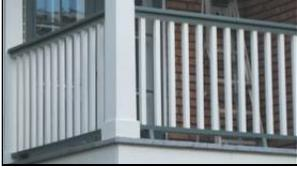
« **balustre** » : colonnettes de forme renflée généralement assemblées à d'autres colonnettes par une tablette à hauteur d'appui. Un balustre peut également désigner l'ensemble des colonnettes nommé « barrotin » qui soutient la main courante d'un garde-corps.
