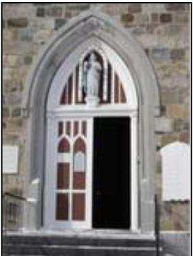
« **ouverture en arc ogival** » : ouverture dont la partie supérieure est constituée d'un arc brisé caractéristique du style gothique dont les deux courbes forment une arête.
