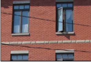
« **bandeau** » : dans un mur de maçonnerie, rangée de briques ou de pierre qui se différencie du reste de la façade, soit par sa couleur, son appareillage ou sa texture de surface.
