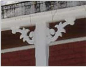
« **aisselier** » : lien de renfort, souvent courbe, portant sur une pièce verticale ou oblique et soulageant une pièce horizontale d'une charpente (entrait). L'aisselier plein est une console. Dans une galerie, pièce de bois décorative située à la jonction d'un poteau et du toit.
