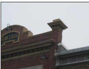
« **amortissement** » : élément ornemental placé au sommet de tout axe vertical d'une élévation faisant partie du couronnement. Exemple, le pinacle sert d'amortissement à un contrefort. L'amortissement est un élément décoratif vertical qui dépasse du parapet ou de la corniche, habituellement en lien avec des éléments verticaux de composition de la façade (exemple : pilastres).
