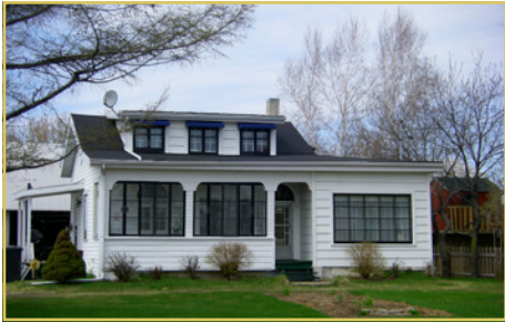
Cette résidence, s'apparentant à un chalet, est dotée d'une belle véranda sur sa façade avant (8510, rue Notre-Dame Ouest).
