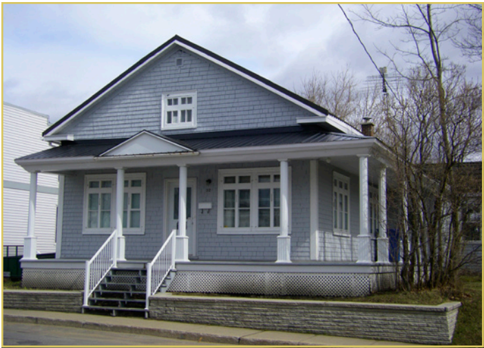
Cette maison en bardeau de cèdre, munie d'une longue galerie couverte sur deux côtés, possède les caractéristiques de l'architecture de villégiature (32, rue Sainte-Madeleine).
