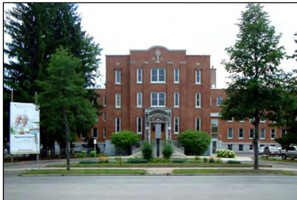
est agrémenté d'une croix en pierre et des lettres M et R. La façade principale est également marquée par des bandeaux de brique verticaux qui créent des avancées et des creux où se trouvent d'étroites fenêtres en bandeau vertical. Les autres façades sont percées par de nombreuses fenêtres rectangulaires à guillotine qui sont distribuées avec une grande régularité. Ce bâtiment imposant est situé sur le boulevard Laviolette, dans un secteur urbanisé de Normanville à Trois-Rivières.
