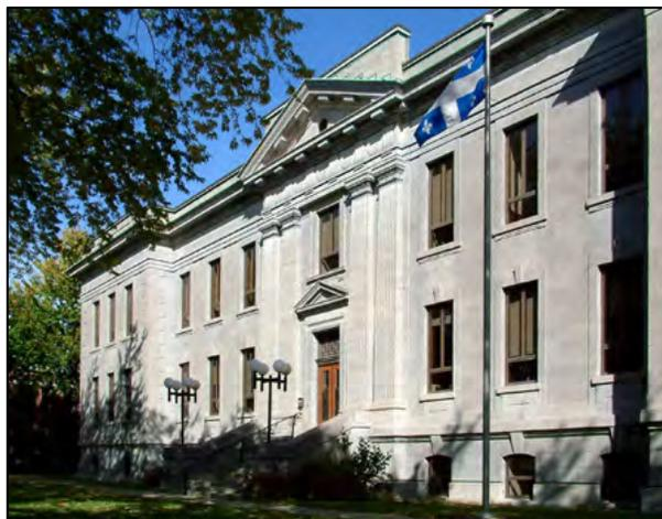
Les fenêtres rectangulaires sont encadrées d'un chambranle en pierre avec un motif de clé de voûte et elles sont disposées avec une grande régularité. Les angles des avancées sont soulignés par un chaînage. Le bâtiment est ceint d'une épaisse corniche et d'un parapet. Le palais de justice est situé sur la rue Laviolette, une artère importante riche en bâtiments institutionnels, au centre-ville de Trois-Rivières.
