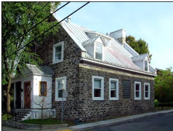
Il possède une porte traditionnelle en bois et donne sur une grande galerie protégée d'un auvent soutenu par des colonnes ouvragées. Sur la façade principale, les cinq ouvertures sont disposées avec symétrie et régularité par rapport aux lucarnes. Des chaînages de pierre sont perceptibles aux angles. Cette résidence est située sur la rue des Commissaires à l'angle de la rue Ferland au centre de Trois–Rivières.
