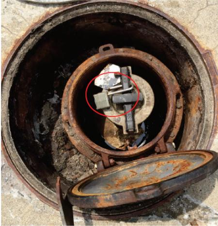
Photo 8 : Réservoir souterrain - Cadenas présent sur le réservoir, mais non barré
