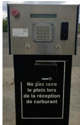
Photo 1 : Système de contrôle d'accès pour les pompes à carburant
