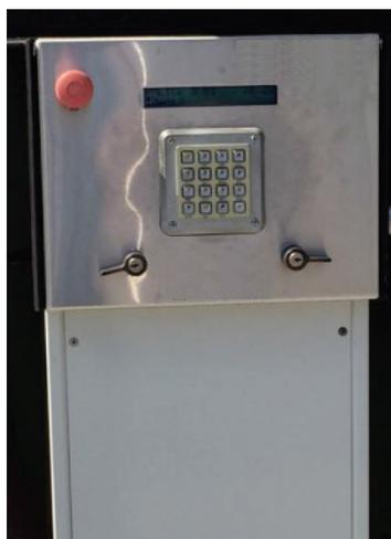
Photo 3 : Terminal du système de contrôle d'accès fermé, mais non barré
